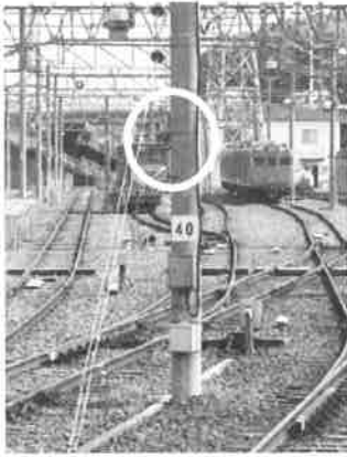
図10 カメラ設置位置(近景)
