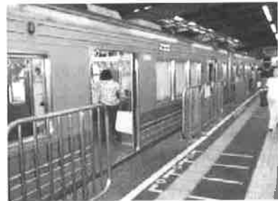
図1 固定ホーム柵の設置例 出所) 国土交通省 [1]
