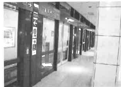
図2 ホームドアの設置例 出所) 国土交通省 [1]
