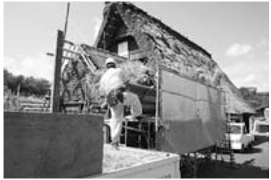
図15. 村内での業者による茅葺き屋根の葺き替え
